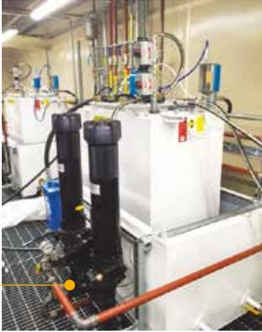
Depósitos hidráulicos con filtros dúplex en línea LMD 431
