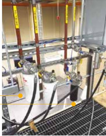
Filtros en línea LMP 210 y MPS Spin-On para diésel, aceite de motor, líquido adblue
