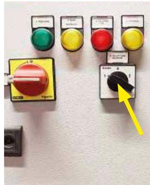
Inverseur de phase uniquement sur les versions avec compteur de particules ICM2.0 Fig.7
