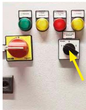
Inverseur de phase unique. Fig.8 sur versions avec compteur de particules ICM2.0
