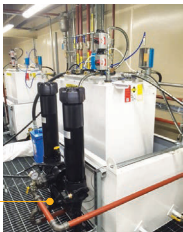
Réservoir hydraulique avec filtre en ligne duplex LMD 431
