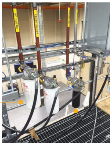
Filtre en ligne LMP 210 et filtre Spin-On MPS pour gasoil, huile moteur et fluide AdBlue
