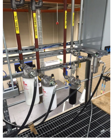
Filtre en ligne LMP 210 et filtre Spin-on MPS pour gasoil, huile moteur et fluide AdBlue
